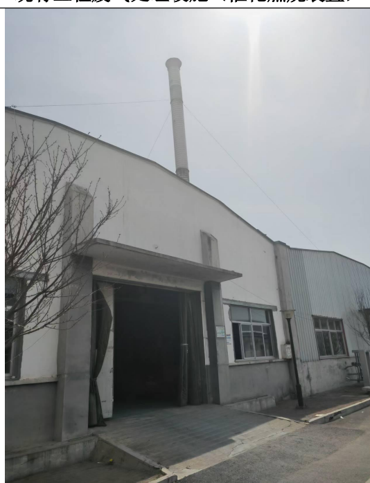
现有工程废气排气筒 DA001
